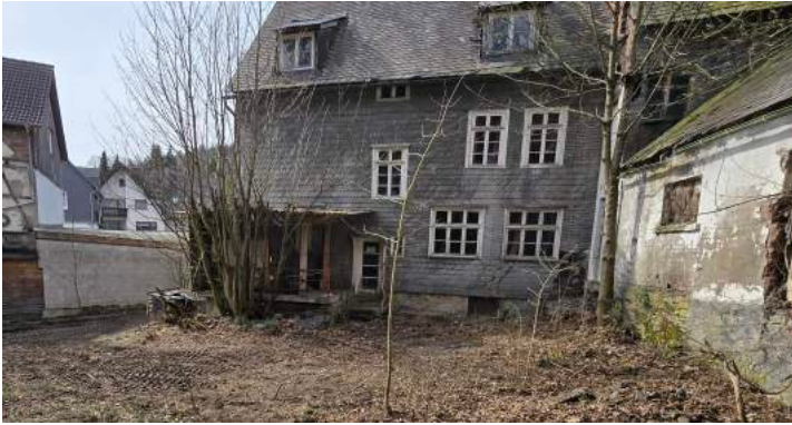
Haus-Rückansicht und Grundstück hinter dem Haus, März 2024
