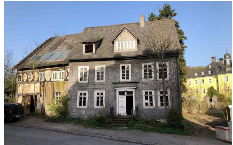
Haupthaus und Anbau links, 10. April 2024
