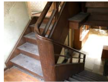
Treppe zum 1. OG, links Zimmer 1, April 2024
